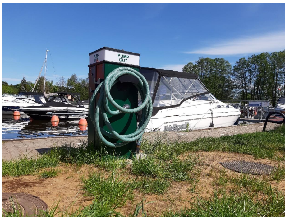
Urządzenie do odbierania ścieków z jednostek pływających, zlokalizowane na terenie Kompleksu Rekreacyjno-Wypoczynkowego Nieporęt-Pilawa
