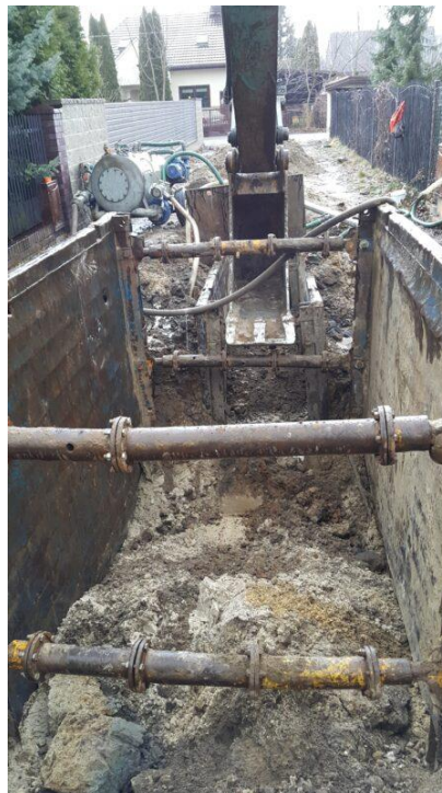
Kanalizacja w ul. Dębowej w Józefowie
