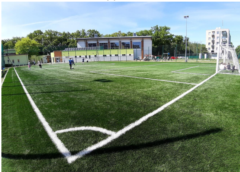
Boisko przy Szkole Podstawowej w Białobrzegach po modernizacji
