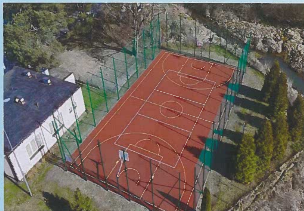
PRZEBUDOWA BOISKA W RYNI
