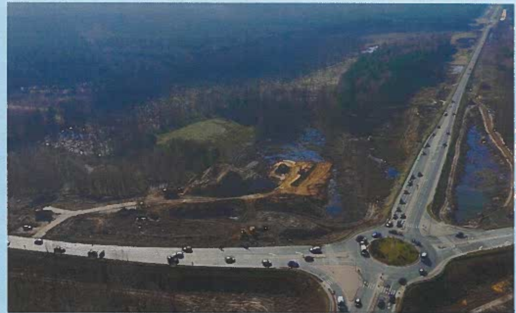
PRZEBUDOWA DROGI NR 61
