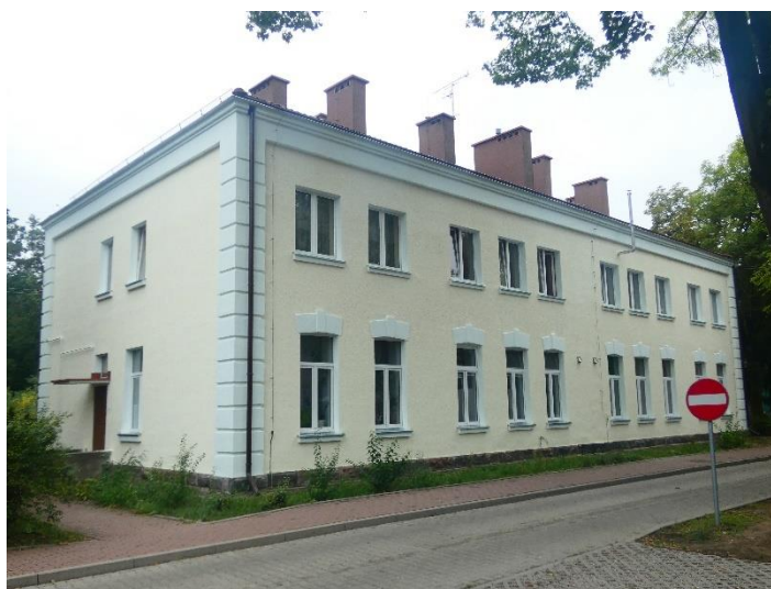
Fot. 4. Zakończone prace remontowe przy budynku na Osiedlu Wojskowym 17 w Białostrzegach
